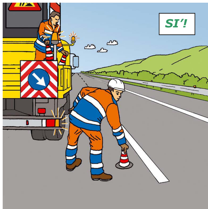
Figura 59 – Posizionamento dei coni o defleco: comportamento corretto
