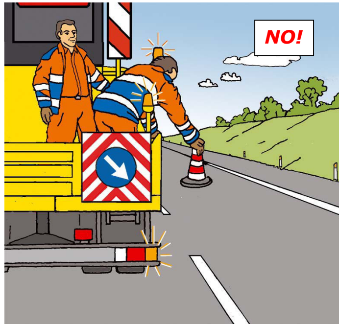
Figura 60 – Posizionamento dei coni o defleco: comportamento scorretto
